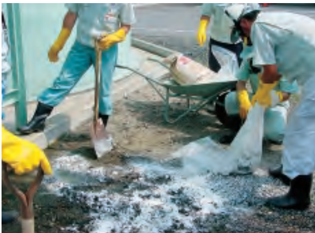
消石灰による土壌の中和作業
